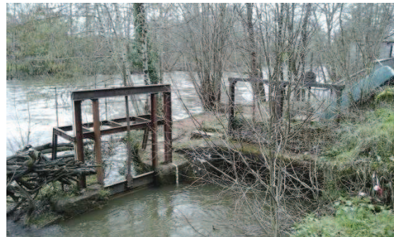
Figure 16 – Vue des trois vannes du seuil
