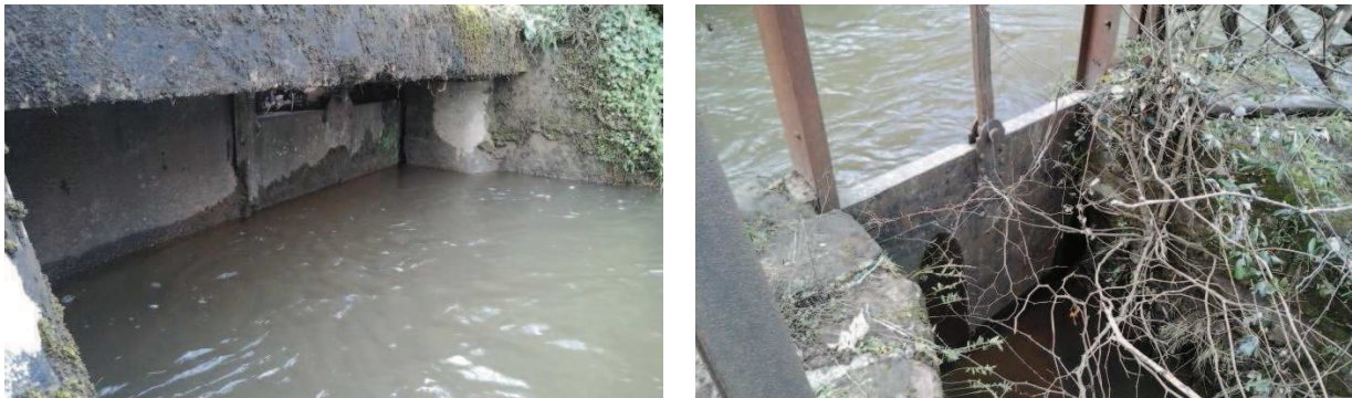
Figure 13 – Vues des vannes levantes existantes
