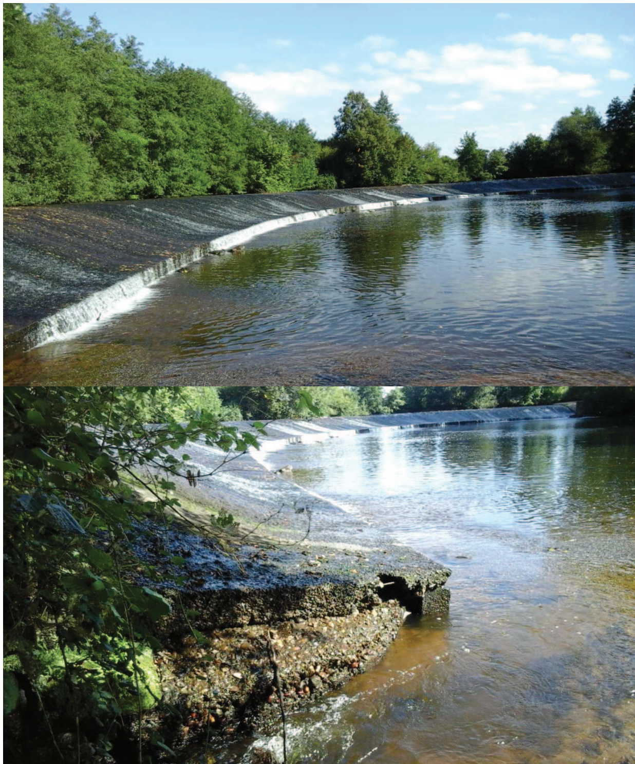
Figure 12 – Vues de la digue en période d'étiage très sévère
