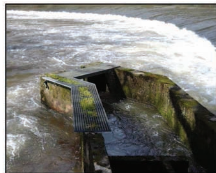
Entrée dans la passe noyée (crue le 10 mars 2016)
